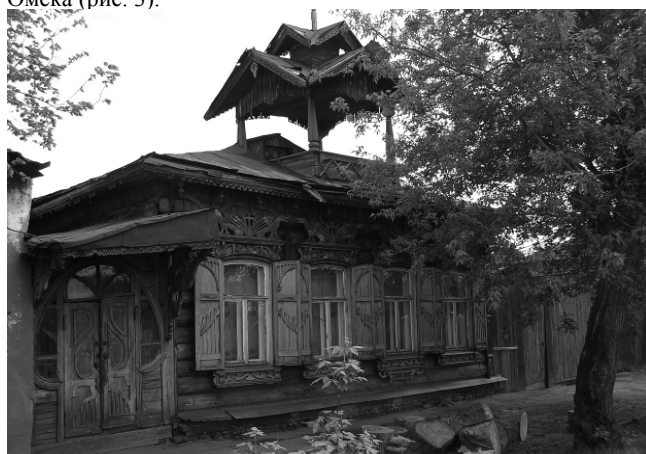
Рис. 3 Жилой дом по ул. Мичурина, 48 в Омске.
