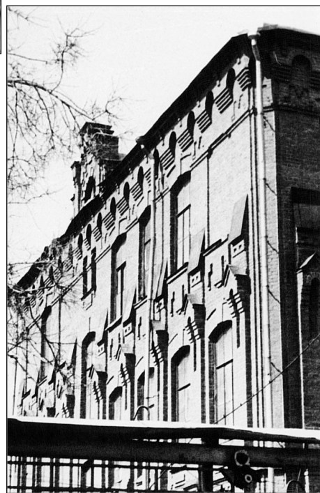
Илл. 4. Склады винной монополии. Фрагмент бокового фасада. 1901.
