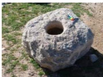
Рис. 14, 15. Каменные базы для деревянных колонн поддерживающих крышу
